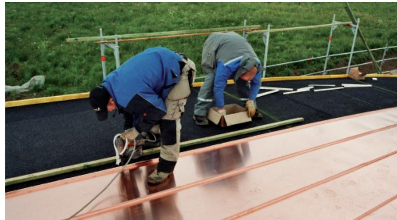
**Mit dem richtigen Werkzeug Zeit sparen: Die Fest- und Schiebehaften werden mit Hilfe eines Haftennaglers befestigt.**
