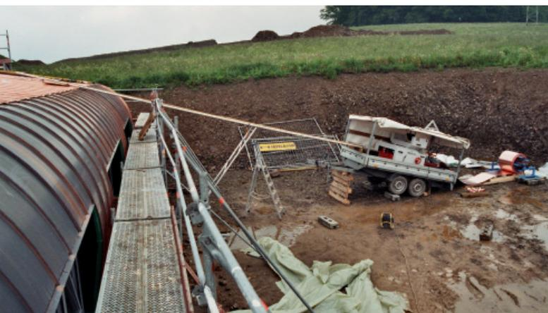
**Baustellenlogistik: Kupferblech vom Coil durch die Profilieranlage über die Rampe direkt auf das Dach.**
