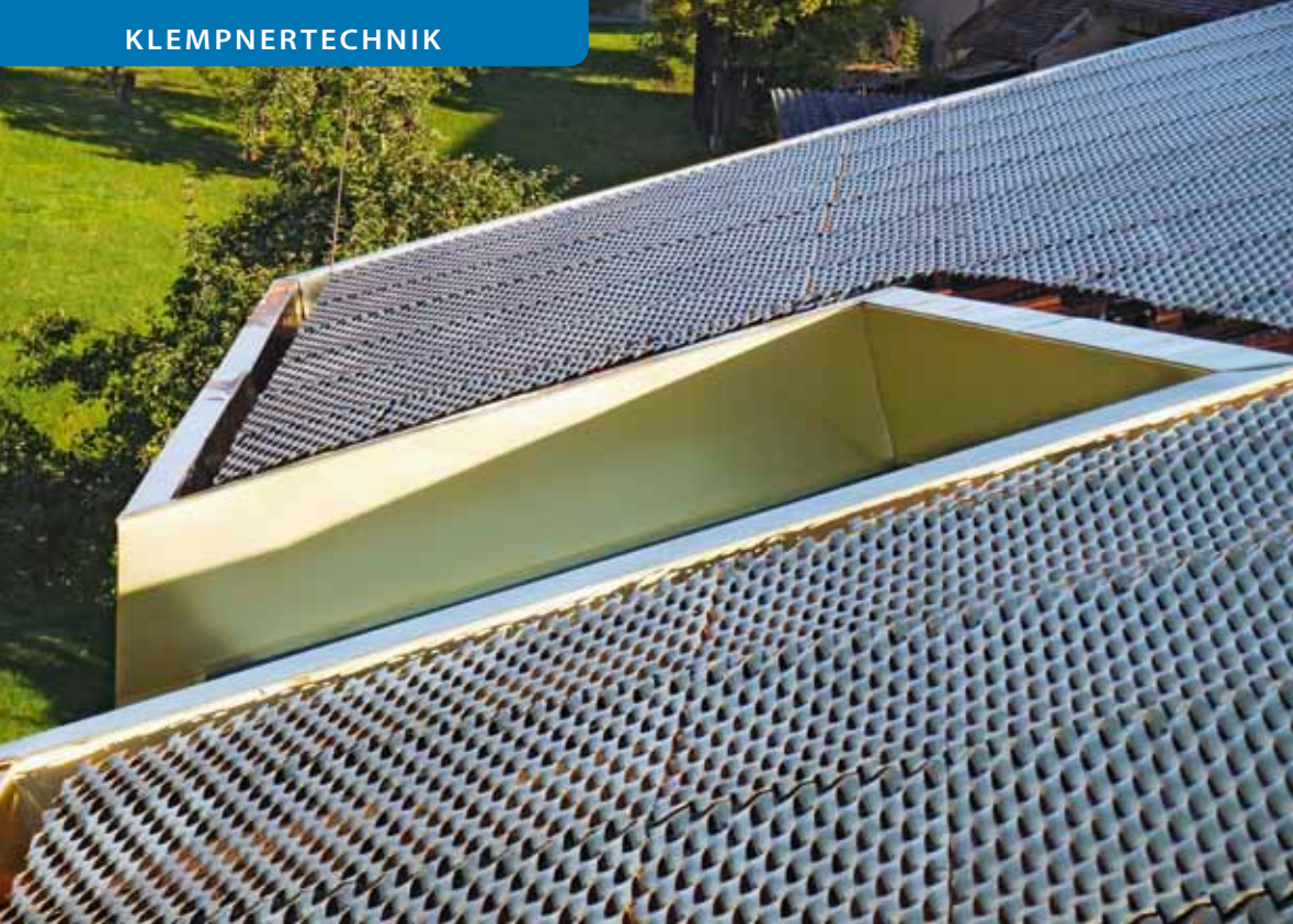
Die Befestigung der Kupfer-Dachverhüllung erfolgte mit speziellen Rohrschellen und mittels Schneefangrohrsystem auf der Doppelstehfalzdeckung.
